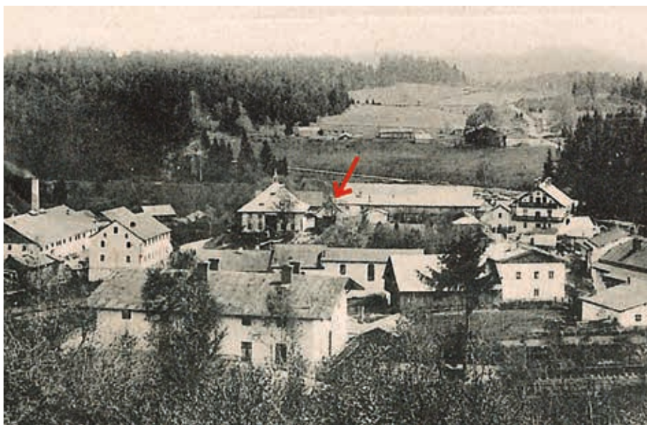
Herrenhaus mit „Stangl-Kapelle“ (Pfeil), Links die neue Glashütte.
